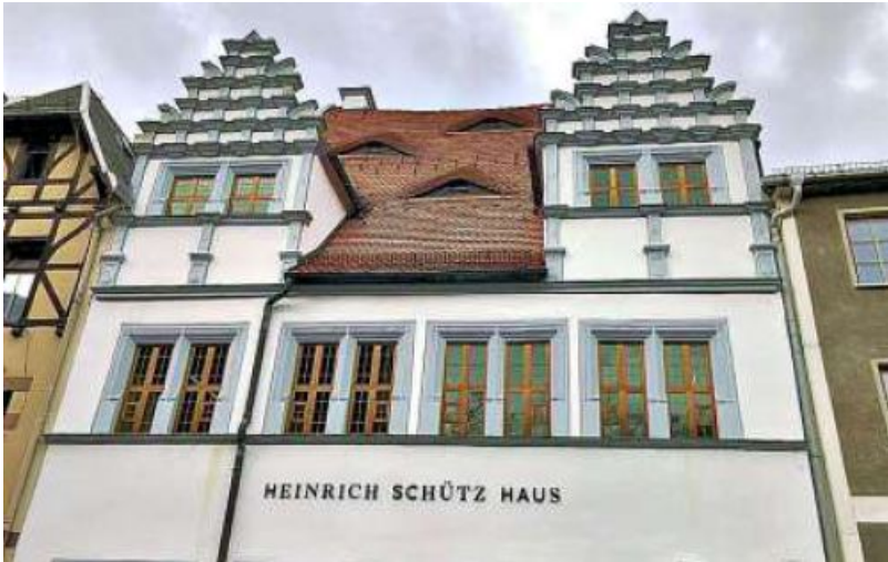
Kein leichter Fall für die Denkmalpflegerin: das Heinrich-Schütz-Haus in der Nikolaistraße, das umgebaut und um einen Anbau erweitert werden soll.
